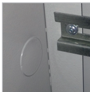
Универсальная металлическая заглушка под боковые отверстия корпуса.
